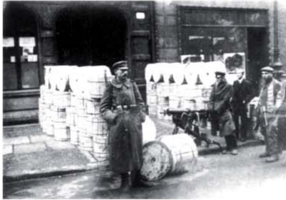
Gazete mahallesinde barikat olarak kullanılan kâğıt merdaneler
